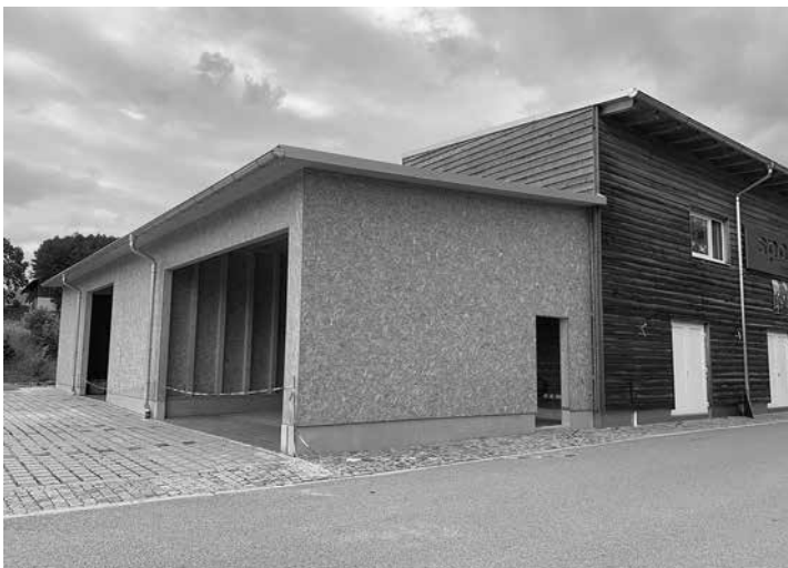
Die Sportwelt mit Rohbau 2. Ausbaustufe.
