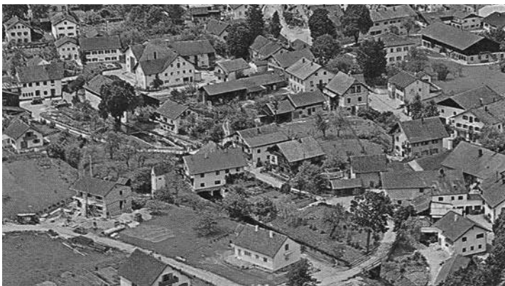
Das Bild zeigt die Kupferbach Siedlung mit den ersten drei Häusern: Am Kupferbach 1, 4 und 6 ungefähr 1960. Bild: F.Hintermaier/Archiv
