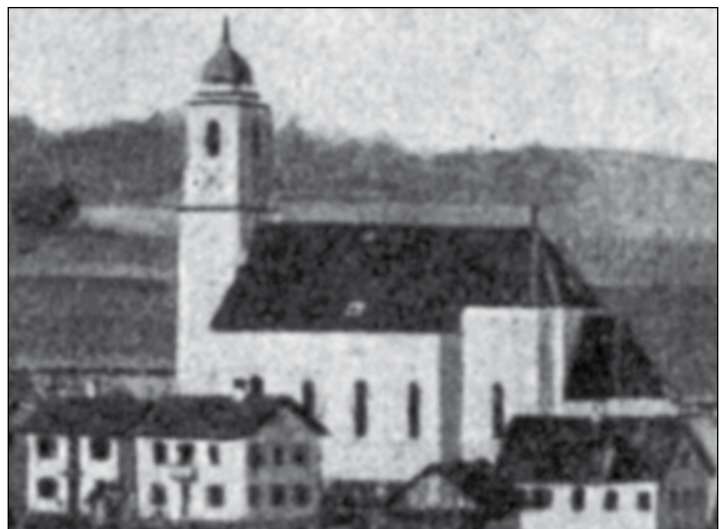
Foto von der Glonner Kirche von ca 1868. Damals noch mit der "welschen Haube". Die jetzige Turmspitze stammt von 1872. Im Vordergrund beim Hitzl, beim Apotheker und beim Melber (heute Lebschehaus genannt). Das Foto dürfte das älteste mit einem Glonner Gebäudemotiv sein.
