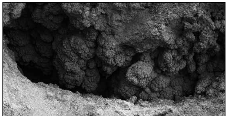
Das Foto entstand beim Aushub des Neubaus der Glonner Raiffeisenbank, so sieht unbehauener Tuff aus. Foto: ho
