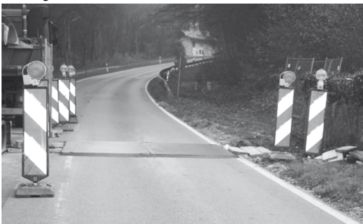
In diesem Herbst konnten fünf Glonner Anwesen, darunter auch der neue Verbrauchemarkt, neu an das Wärmenetz angeschlossen werden. Hier auf dem Foto der Anschluss des Forsthauses an der Zinneberger Straße. Foto: cg
