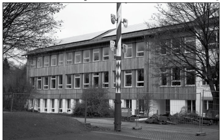
Fast wie neu ist das Schulhaus nach der energetischen Sanierung. Foto: cg
