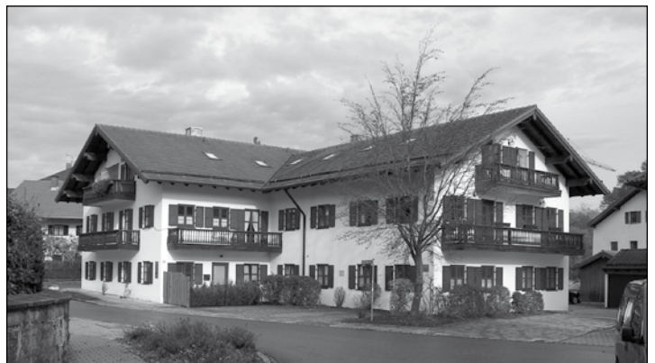
Das ehemalige Huberwirtsanwesen ist heute ein großes Wohn- und Geschäftshaus. Foto: sk
