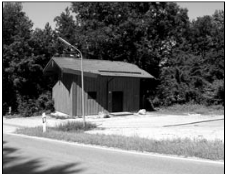
Neben dem Pumphebewerk an der Zinnebergerstraße soll die Heizzentrale für eine künftige Nahwärmeversorgung entstehen. Foto: sk
