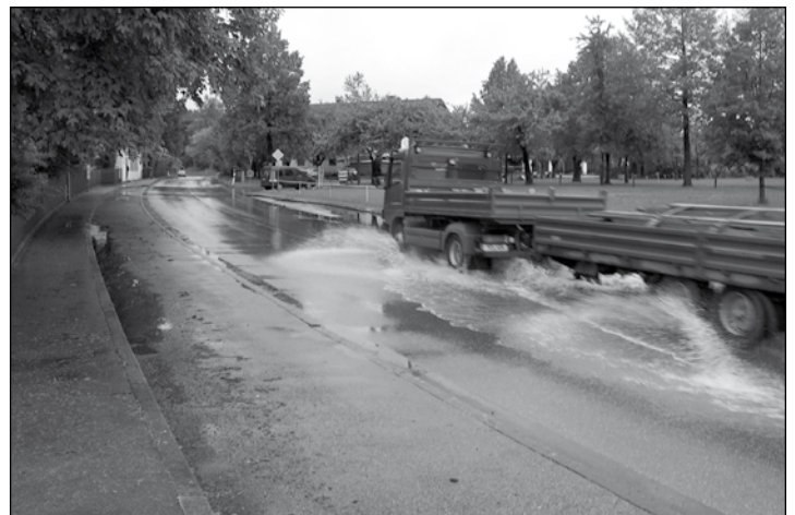
Durch die Beeinträchtigung des ursprünglichen Ablaufes auf der Südseite des Kastensees wird die Kreisstraße auf der Nordseite verstärkt geflutet. Als Ursache werden waldwirtschaftliche Maßnahmen vermutet. Foto: sk
