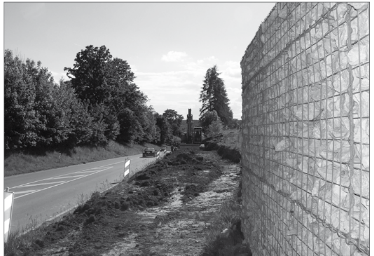
Der Gehwegbau nach Wetterling macht gute Fortschritte, trotz schwierigen Geländes haben sich die Bagger den Weg hochgraben und Wetterling erreicht. Foto: sk
