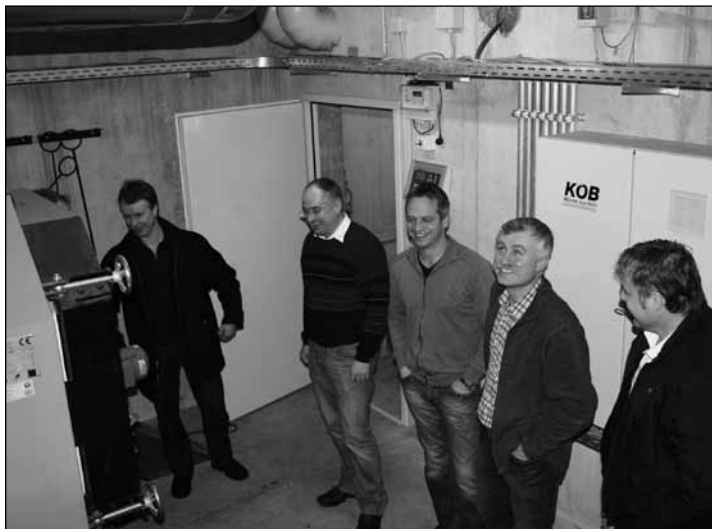
Mitglieder des Gemeinderates und Verantwortliche der Gemeindewerke bei der Besichtigung der Holzhackschnitzelanlage Wetterling. Foto: Gerneth
