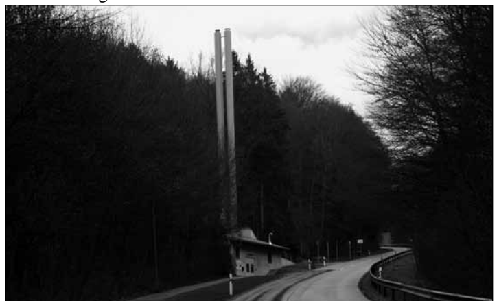
Das Holzhackschnitzel-Heizwerk arbeitet mustergultig – so das Fazit der Betreibergesellschaft. Foto: Gerneth
