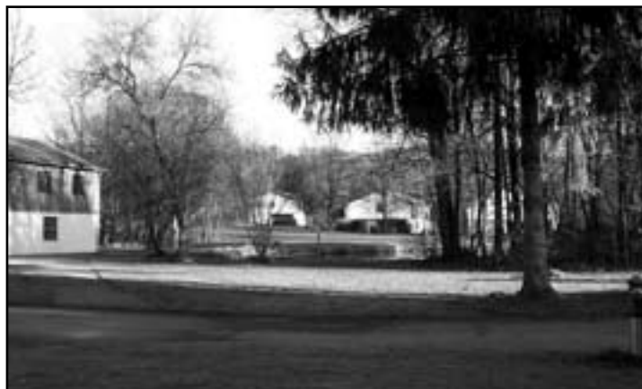
Von außen noch ganz nett anzusehen, aber ohne Ausnahme Sanierungsfälle: Die ehemaligen Piusheimer Gruppenhäuser. Foto: cg
