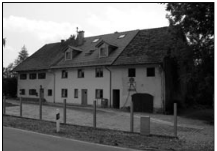
Nachdem der Mittelteil saniert wurde, kommt nun die Tenne, bzw. der Stadel an die Reihe.
